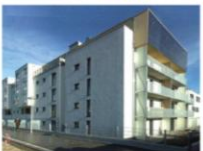
6. Roschégasse 20 A:H Treburspurg & Partner Architekten ZT GmbH
